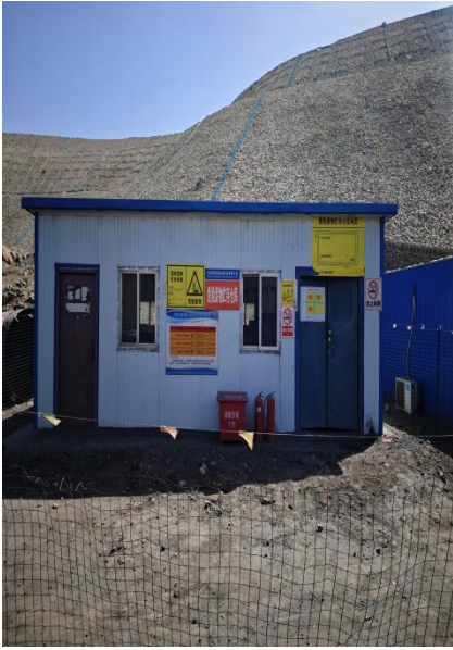
危废暂存库外部
