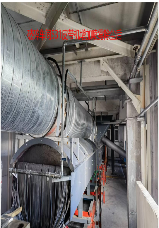
筛分破碎站的喷雾除尘设备和烧结板除尘器
