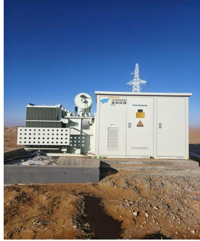
3#风机 (T07) 箱式变压器和事故油池
