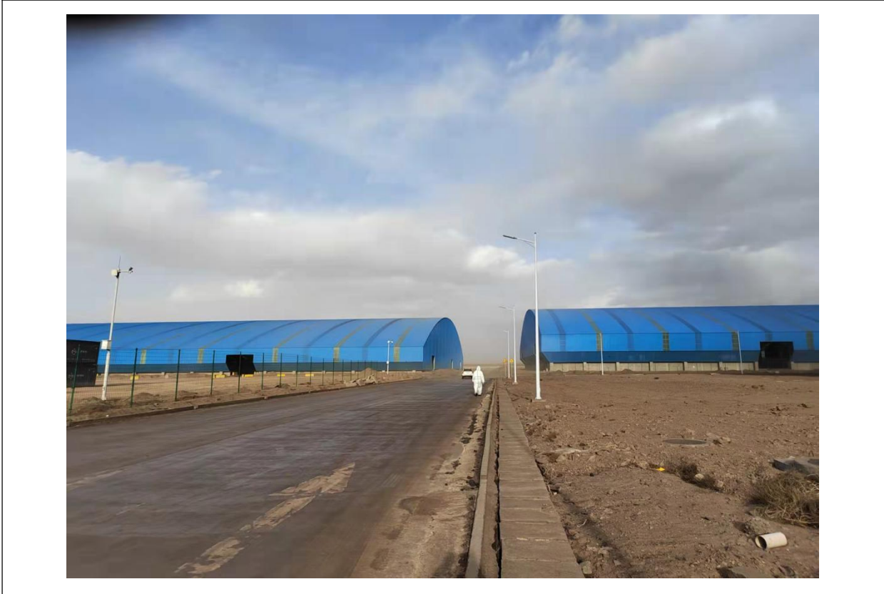
4 号及 5 号储煤棚
