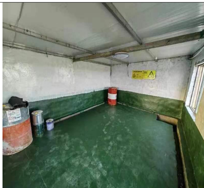
危废暂存间内部
