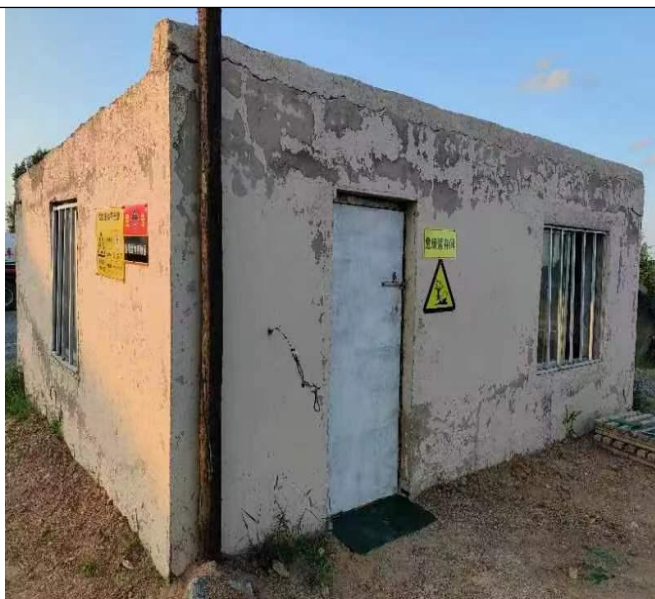
危废暂存间外部
