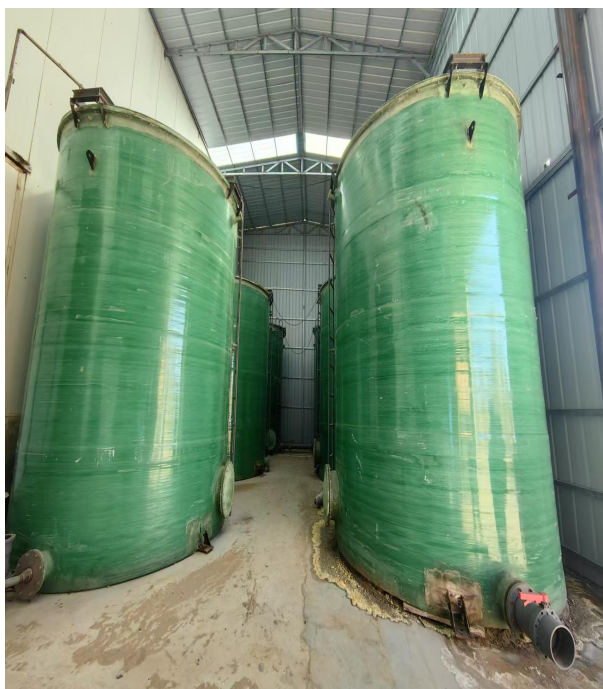
母液罐（硫酸钠）、母液罐（氯化钠）、母液罐（杂盐）、草酸储罐、PAM 储罐、PAC 储罐、次氯酸钠储罐
