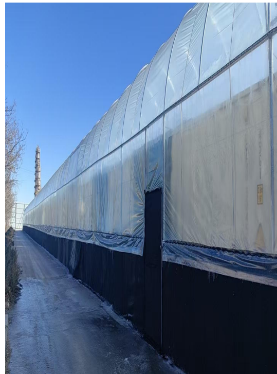
冷凝水生化处理系统
