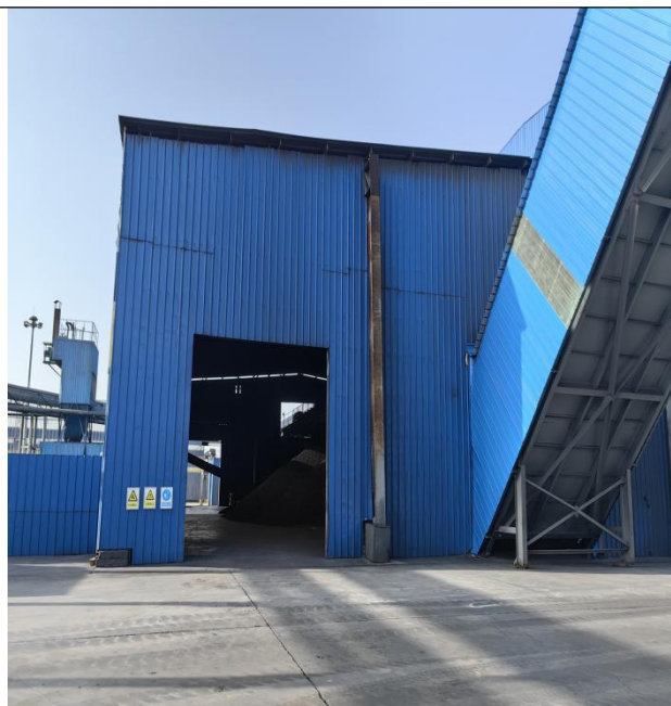
全封闭储料棚南侧
