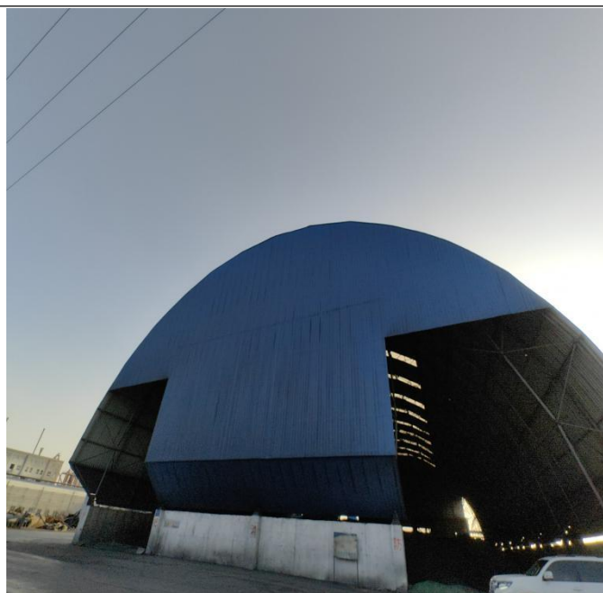
全封闭储料棚东侧
