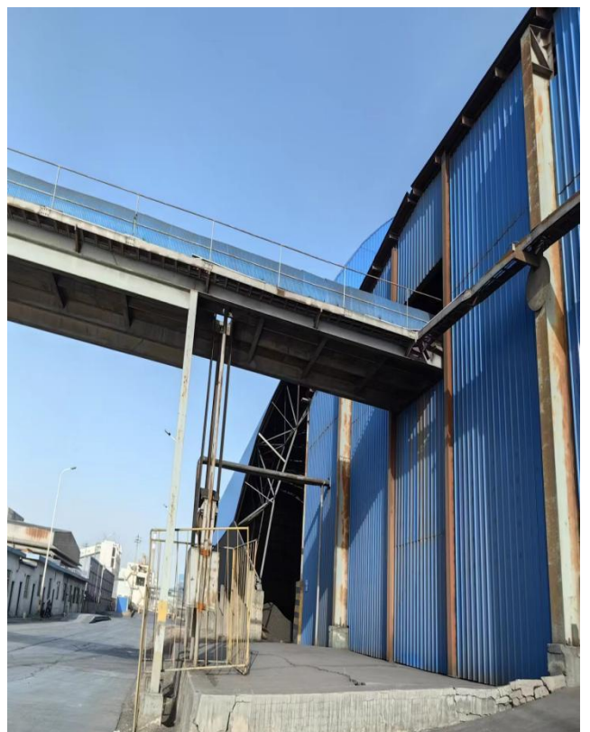
全封闭储料棚北侧及道路
