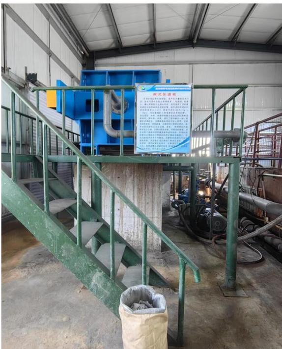
脱水系统-板框压滤机
