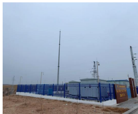
开关站周边植被恢复
