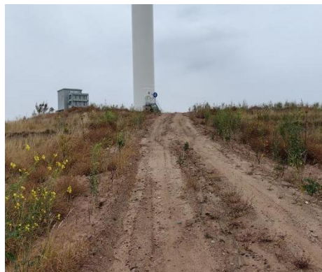
检修道路两侧植被恢复
